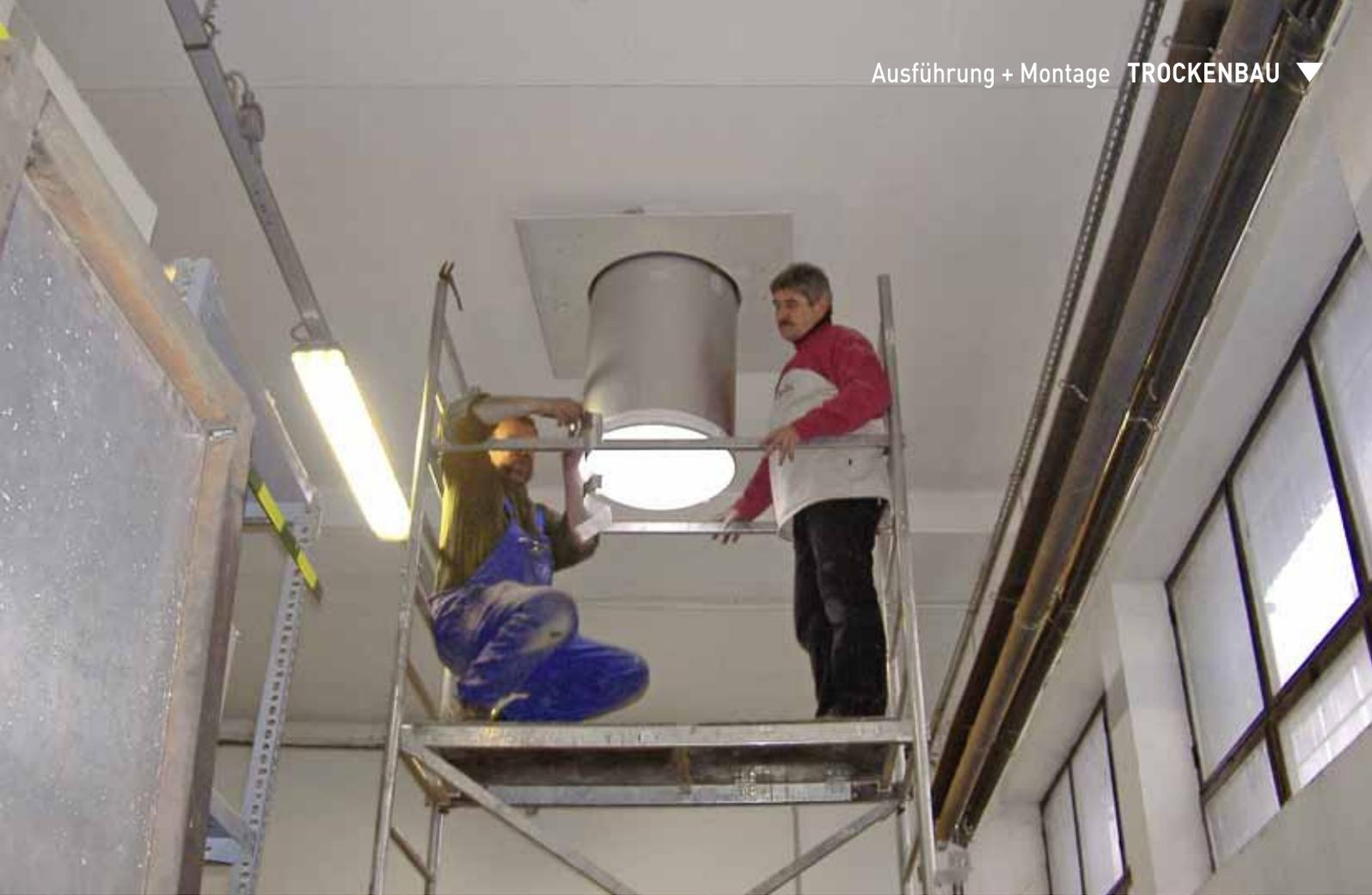
Die Montage einer Sonnenröhre stellt für Trockenbauer nach einiger Übung keine Herausforderung mehr dar und ist meist in deutlich weniger als einer Stunde pro System getan
