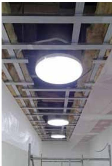
Hat der Trockenbauer eine Rasterdecke abgehängt, wird einfach ein entsprechendes „Solatube“-Deckenelement in diese eingelegt
