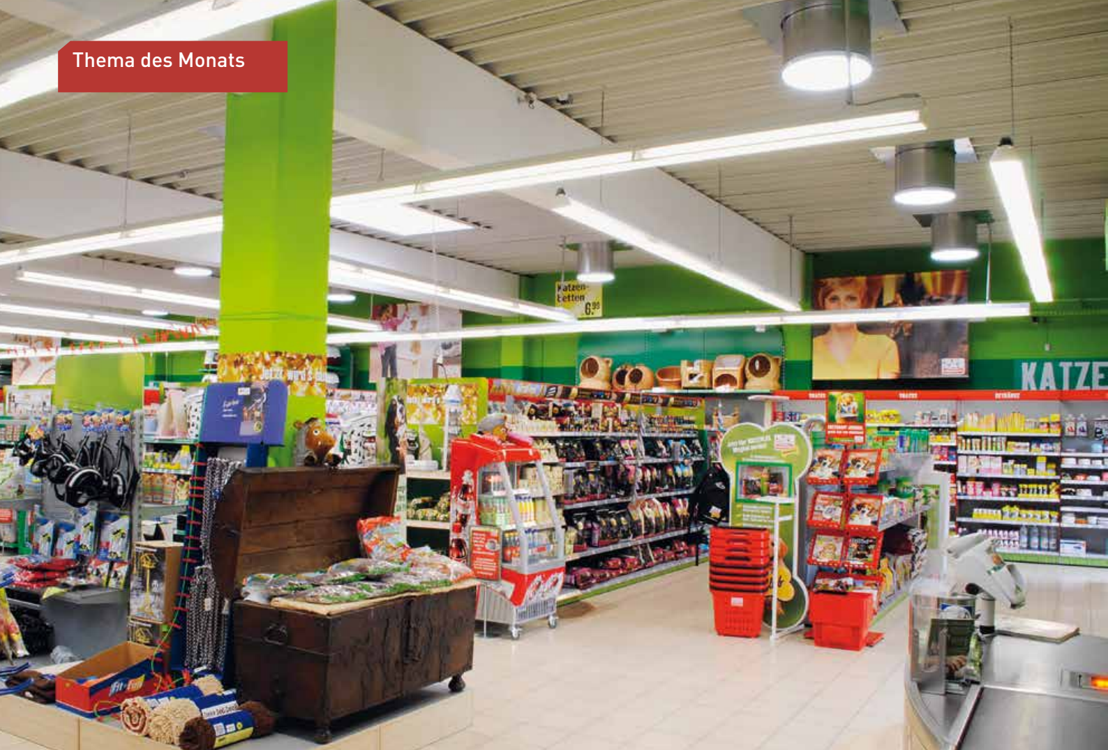
▲ Strompreis halbiert: Das 750 m 2 große Ladenlokal bei Köln wird seit Kurzem mit einem Mix aus Tageslicht und Kunstlicht beleuchtet
