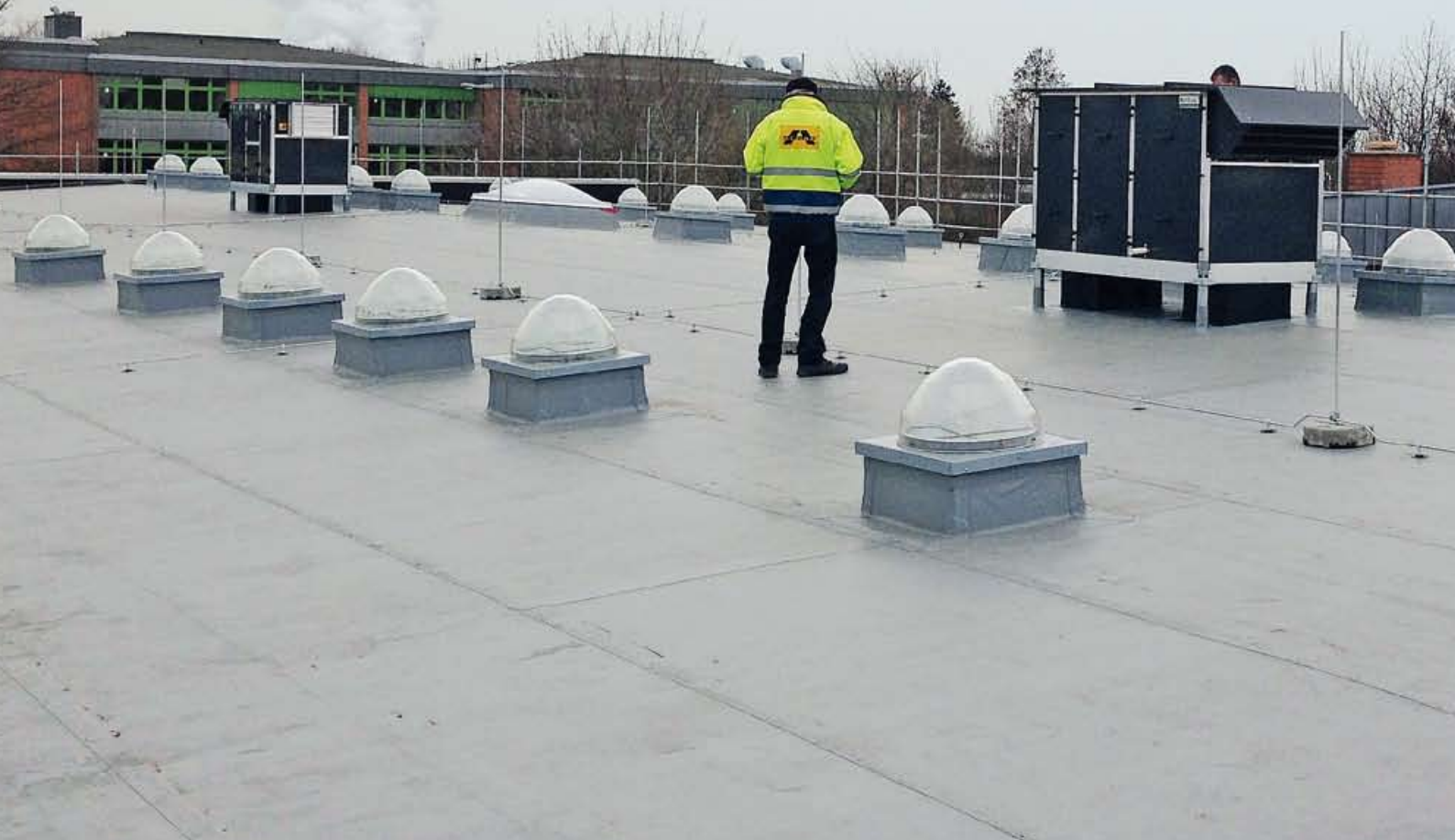
▲ Vorbildcharakter: Die Montage der Sonnenröhren führte ein Fachmann des Herstellers auf der Baustelle in Langerwehe bis ins kleinste Detail vor
