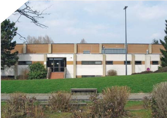
▲ Die Turnhalle in Langerwehe wurde umfassend saniert. Dabei kamen für die natürliche Belichtung 39 Tageslichtsysteme zum Einsatz
