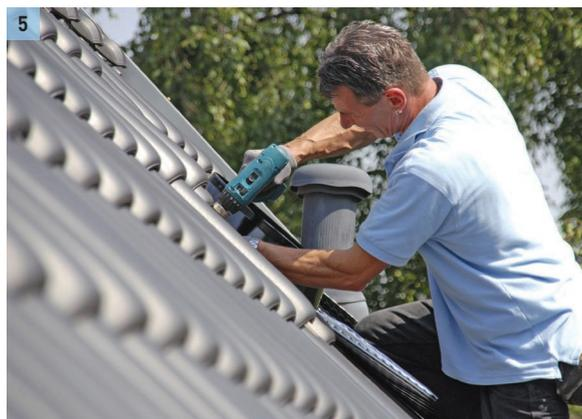
**5** Danach oben und seitlich Kehldichtstreifen aufkleben und die Ziegel bedecken (gegebenenfalls schneiden)
