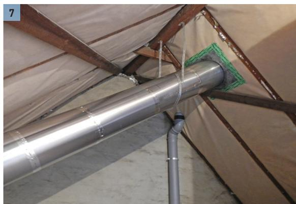
**6** Nun das Dachanschlussrohr von oben durch den Dachanschluss einsetzen und am Dachanschluss verschrauben
