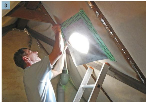
**4** Außen die Unterspannbahnmanschette an die Unterspannbahn andichten. Den Dachanschluss auflegen, rechts und links um- sowie oben zurückkanteten. Seitlich den Dachanschluss mit Haftband befestigen
