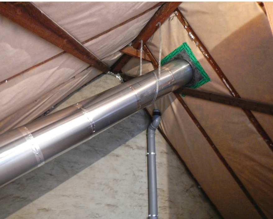
Die Rohrverlängerung im Innenraum wird an die Dachmanschette zum Außenbereich angeschlossen. Danach werden die Rohre durch den Innenraum gelegt ... Fotos: Interferenz Daylight
